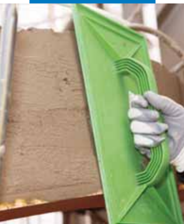
Frattazzatura di Planitop 430
