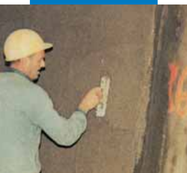
Intonaco cementizio con Planicrete. Cantiere Tunnel autostradale Ville Marie Montreal - Canada
