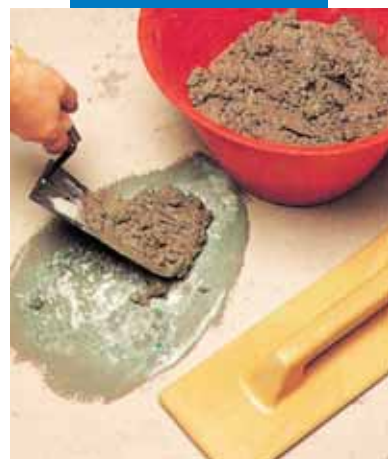
Rappezzo di pavimento: applicazione malta
