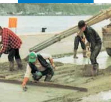
Massetto cementizio esterno additivato con Planicrete. Cantiere Vieux Port, Quebec, Canada
