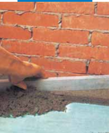
Applicazione di massetto cementizio aderente additivato con Planicrete
