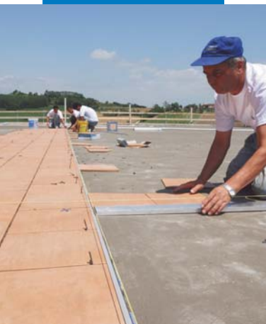
Posa di ceramica con Kerabond + Isolastic
