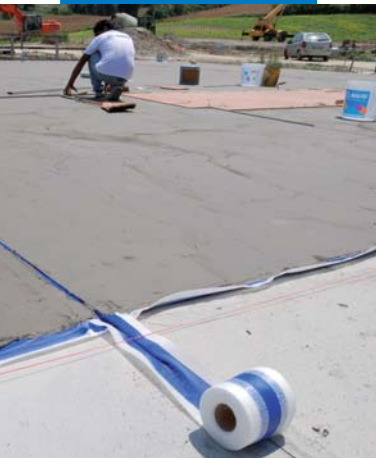
Impermeabilizzazione dei massetti con Mapelastic e Mapeband
