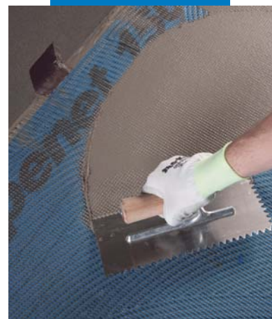
Stesura di Mapelastic su Mapenet 150
