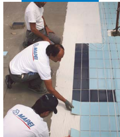
Posa di rivestimento ceramico su Mapelastic
