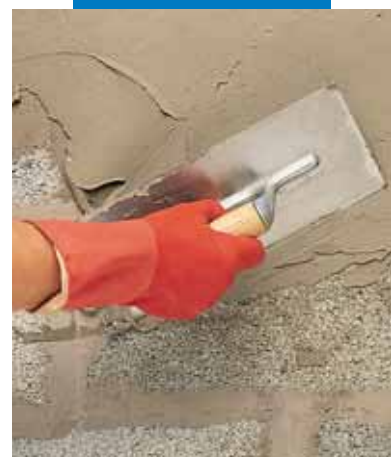
Applicazione di Idrosilex Pronto a spatola
